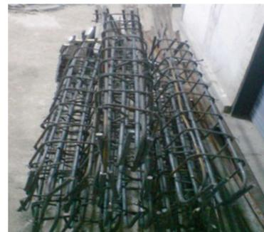
شکل ۸- نحوه بستن شبکه آرماتور و آماده‌سازی و روغن زدن قالب‌های فلزی
