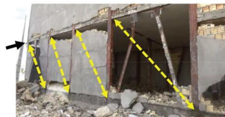
شکل ۸- تحمل بخشی از بار جانبی از طریق شکل گیرنده دستک قطري فشاری دیوار پرکننده
