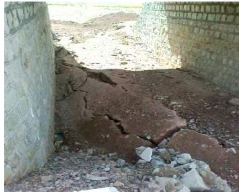
شکل ۴- انتهای زمین لغزش روشک در فاصله بین دو پایه پل
