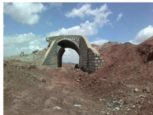
شکل ۵- تخریب پل سنگی در اثر لغزش زمین روشک
