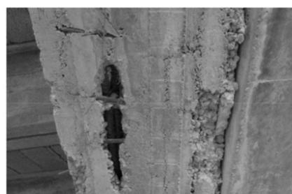
(الف) تراکم آرماتور طولی و همچنین عدم رعایت پوشش بتُنی روی تیر
