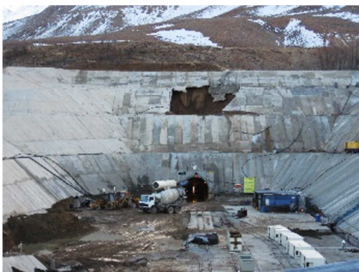
شکل ۴- حفره ایجاد شده در دهانه ورودی.
