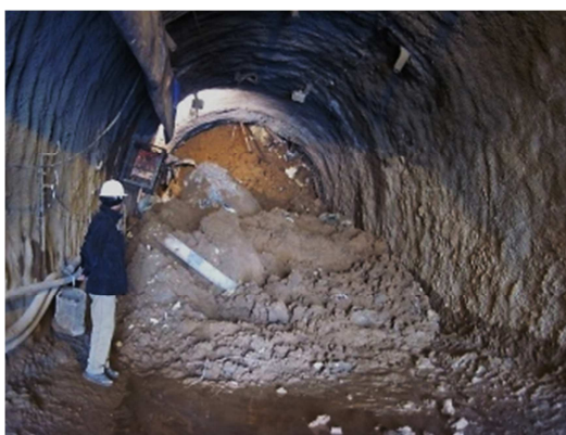
شکل ۳- ریزش تونل سبزکوه.
