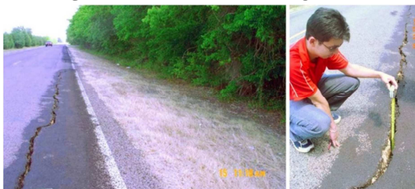
(پ) وقوع ترک کششی در روسازی راه به دلیل نشست نامتقارن لایه‌های زیرین خاک [۳]
