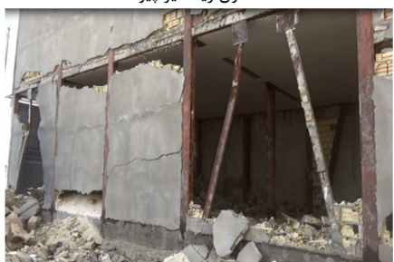
(و) اتصال دیوار به سازه مهاربند برون محور
