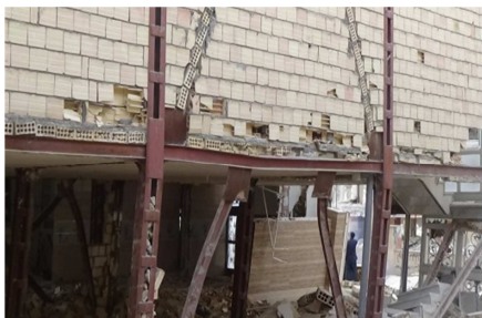
(ب) عدم اجرای سخت کننده در تیر پیوند
