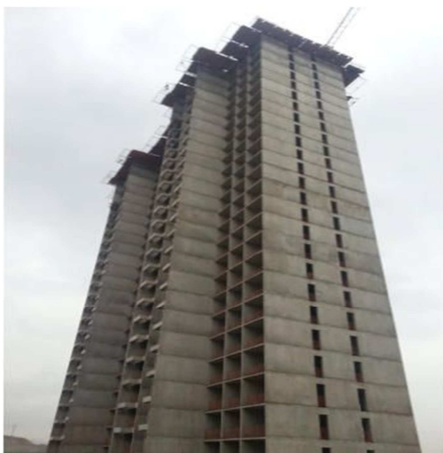
شکل ۱- تیرهای پیوند در وجه پیرامونی یک ساختمان با سیستم سازه‌ای جعبه‌ای شکل
