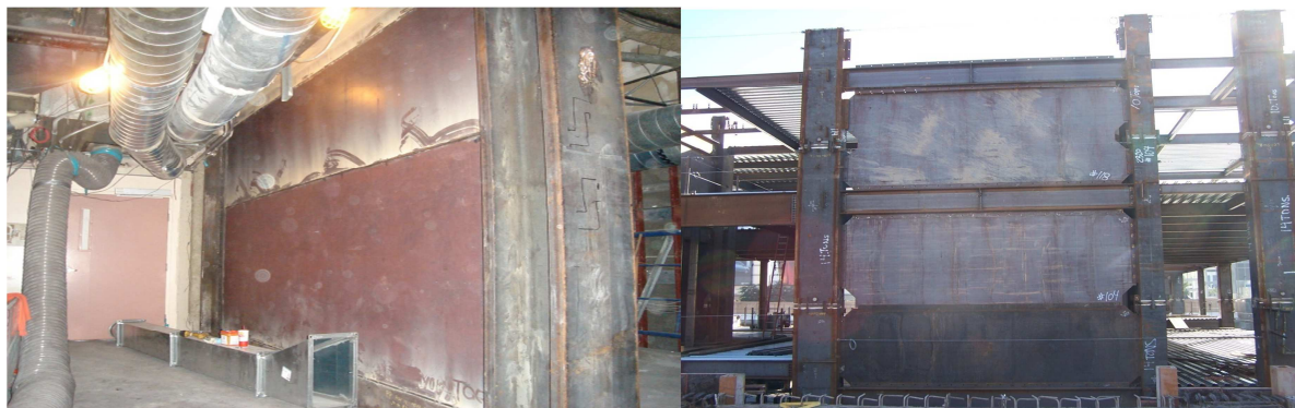
شکل ۱- نمونه اجرایی دیوار برشی فولادی
